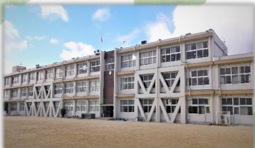
●現藤尾小学校舎
